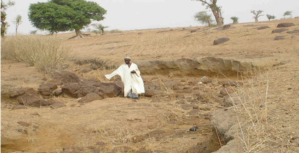
Ravinement du sol, suite à l'érosion hydrique
